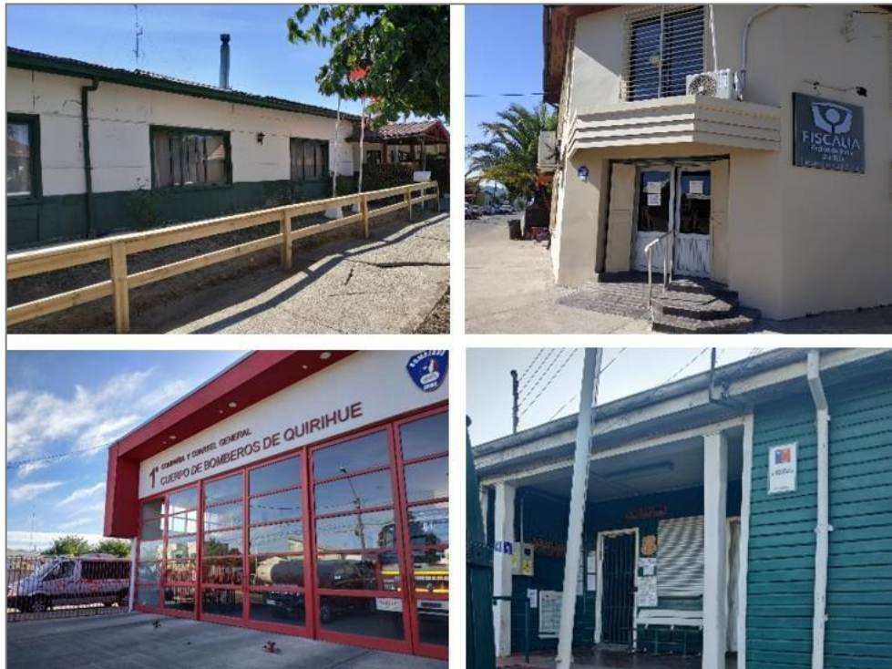
Imagen 14: Fotografías equipamiento de seguridad zona urbana de Quirihue
