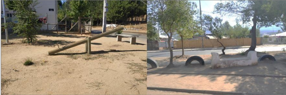
Imagen 18: Fotografías plazoletas en malas condiciones zona urbana de Quirihue
